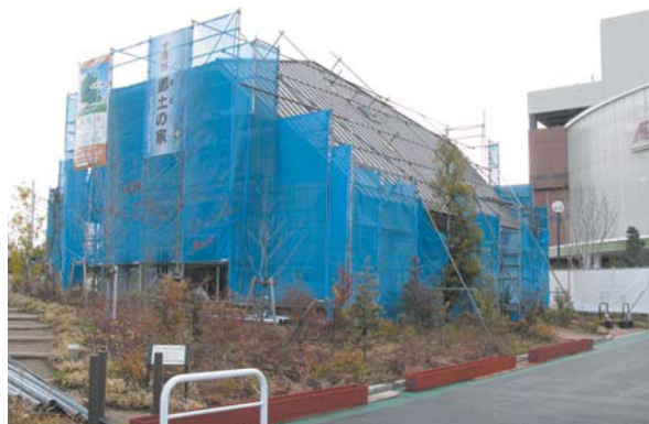
「十津川の森」で建築中のパッシブハウス
