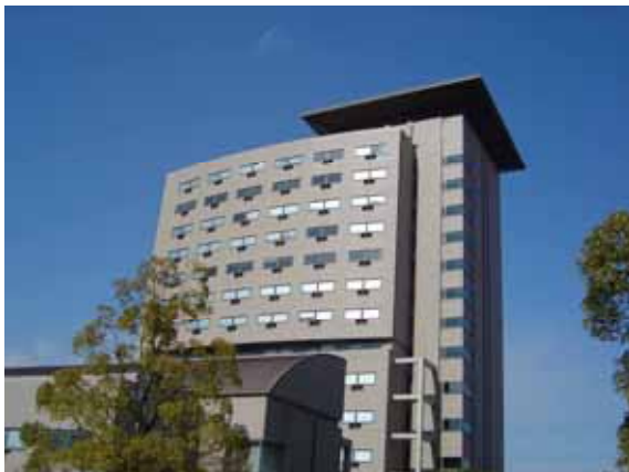
(株)ジーネスが入居する、けいはんなプラザラボ棟
