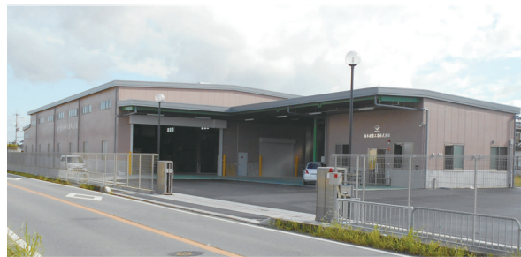
9月に竣工した第二工場
