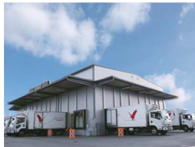
ドックシェルター完備の冷凍・冷蔵倉庫 (左)
