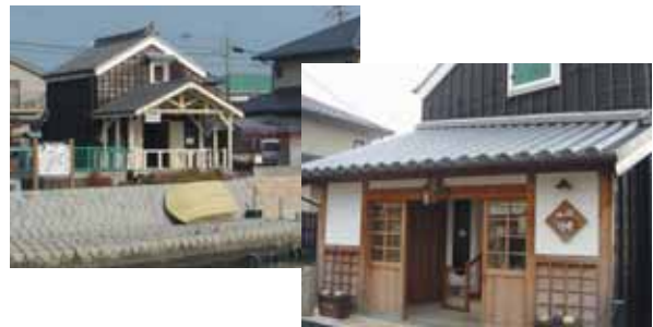
醤油蔵を改修した「河崎・川の駅」
