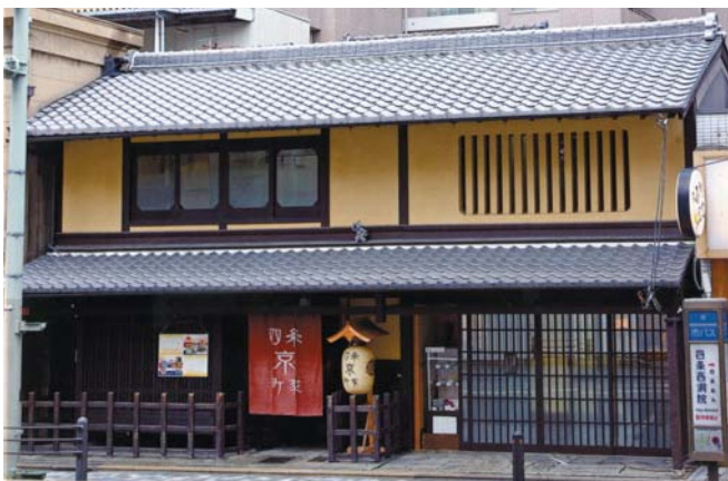
明治43年築の町家を再生、一般公開している「京都市伝統産業振興館」
