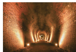
1892年に完成した鉄道跡「亀瀬隧道」。崩壊したと思われていたが2008年に再発見され、現在一般公開されている(写真提供:風の郷 龍田古道プロジェクト)
