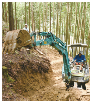
作業道の整備（上）
