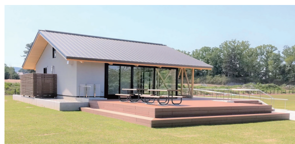
整備が進められる郡山城跡公園の「郡山城情報館」
