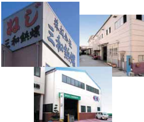
株式会社三和鋳螺製作所の本社・工場
