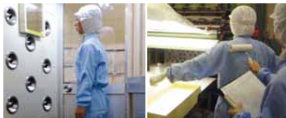
エアシャワー室
