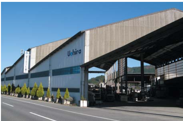
植平コンクリート工業株式会社の本社工場
