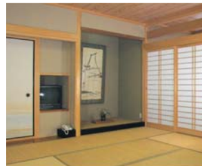
吉野材の木目が活かされた集成材。無垢材の約1.5倍の強度がある。
