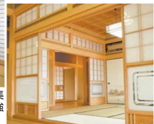
吉野材の木目が活かされた集成材。無垢材の約1.5倍の強度がある。
