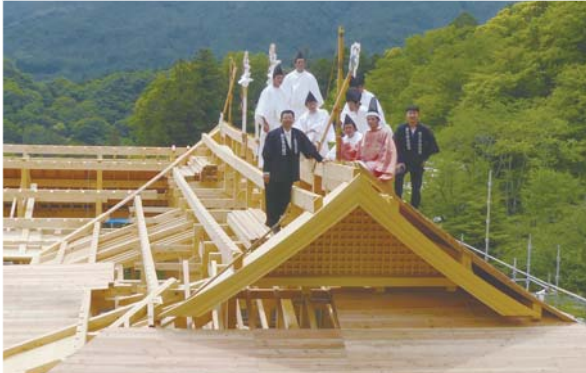
長谷寺本願院（桜井市）の上棟式の様子。伝統の通り、大工棟梁の振幣の合図と共に、棟上で天の矢・地の矢の脇で槌を打つ「槌打ちの儀」を行う。
