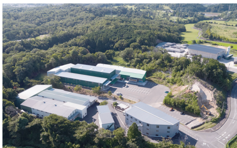
同社のロゴタイプ（上）本社工場・倉庫の全景（下）
