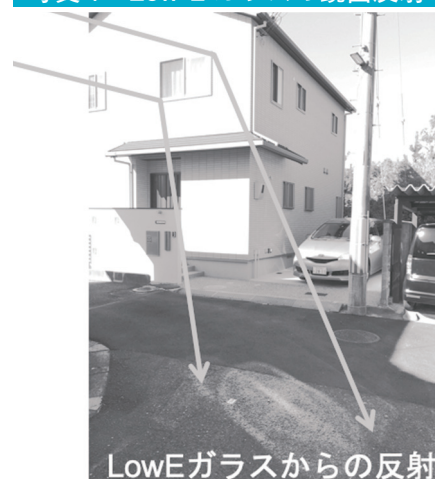
写真1：Low-E ガラスの鏡面反射
